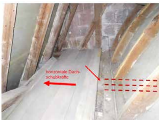
Bild 7: Die ursprünglich durchlaufende Zerrbalkenlage wurde für das Spantengewölbe zerschnitten
